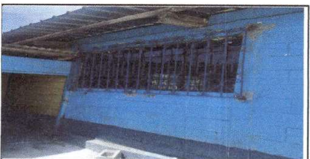
Foto 6: Cambio de balcones
