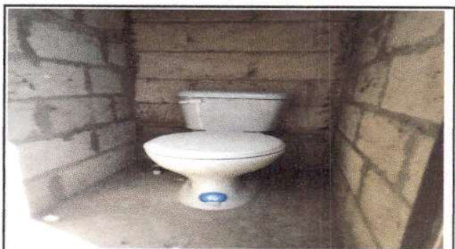
Foto 4: Cambio de sanitarios en mal estado
