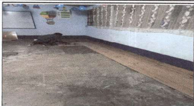
Foto 2: Cambio de piso de cerámico
