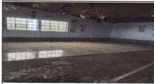
Foto1: Cambio de piso de cerámico
